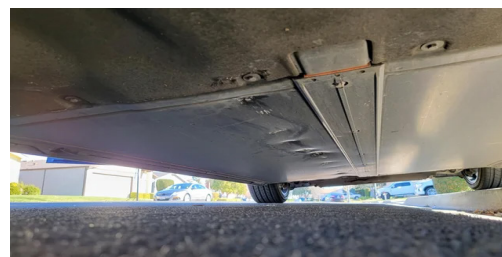
Beschädigung am HV-Energiespeicher
