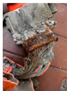
Oxidation am HV Kabel Oder dessen Abschirmung
